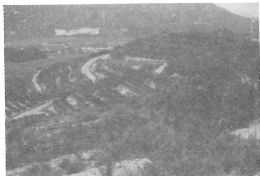
防風林が整備された傾斜面 テラス状みかん園
