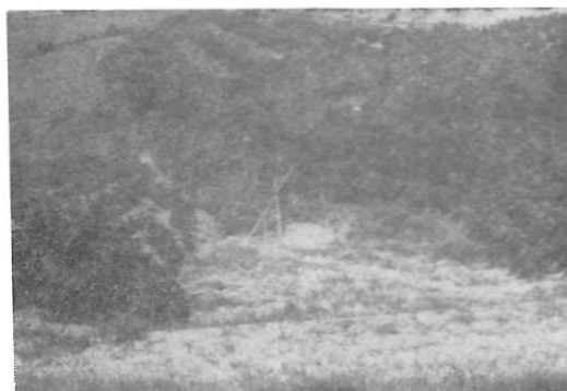
テラス状みかん園の土砂くずれ現地
