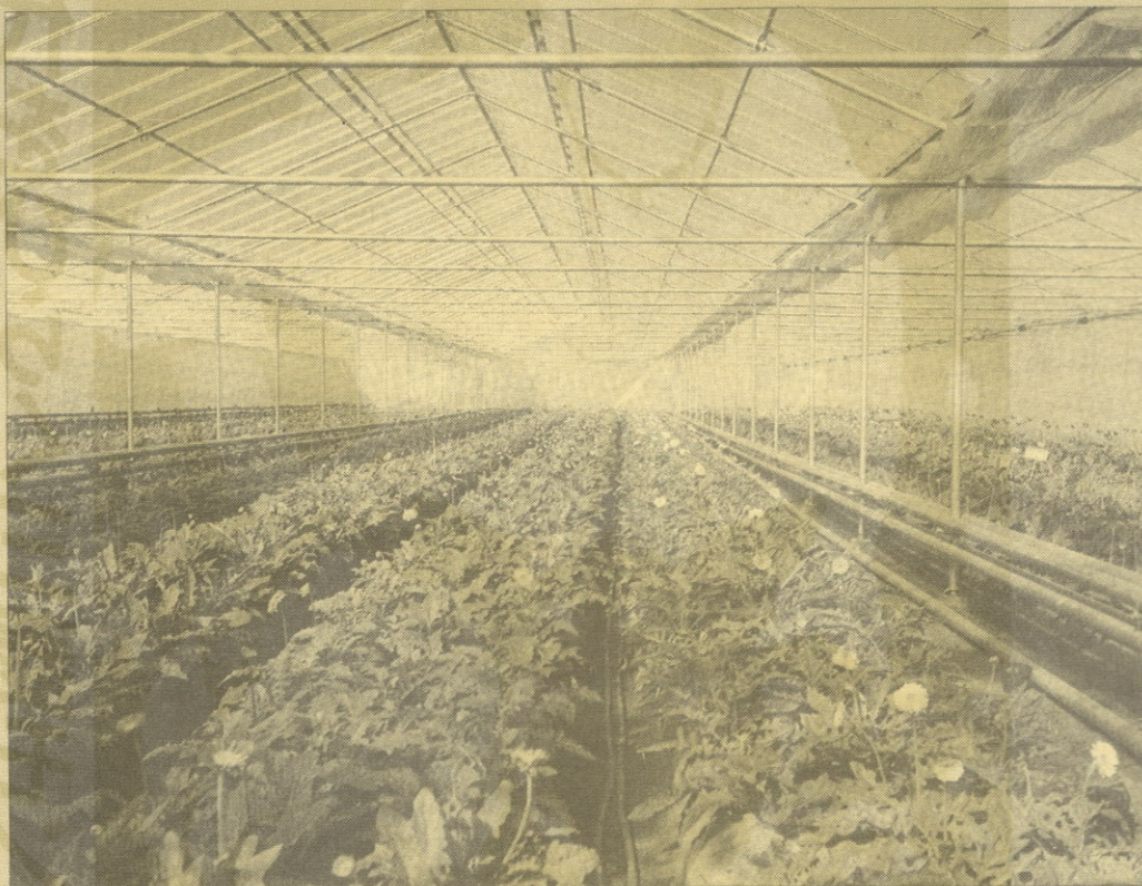
千葉県山武郡横芝町・林雅彦様サンダッシュハウス（シクスライトフィルム展張天窓巻取り換気方式）
