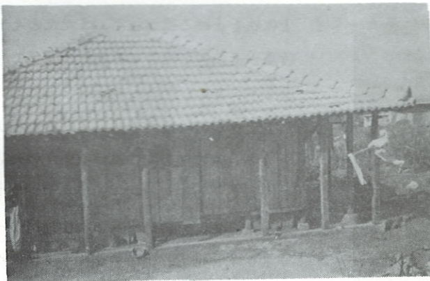
第7図 軒先の長く出た沖縄の家 (倒壊後仮に復旧したもの)
