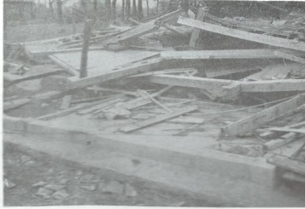
第8図 倒壊した家屋
